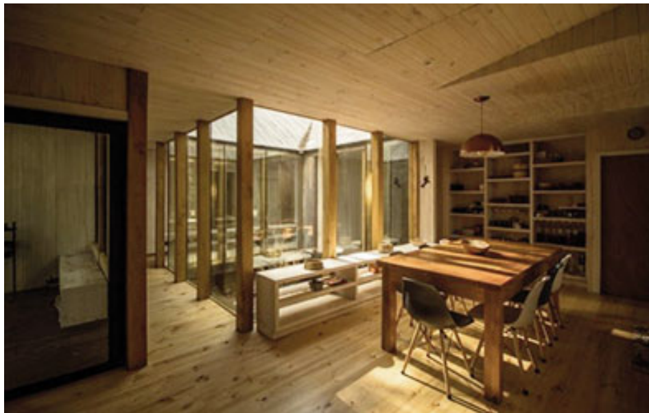
Los pilares interiores perimetrales del patio de luz fueron diseñados con maño seco.
