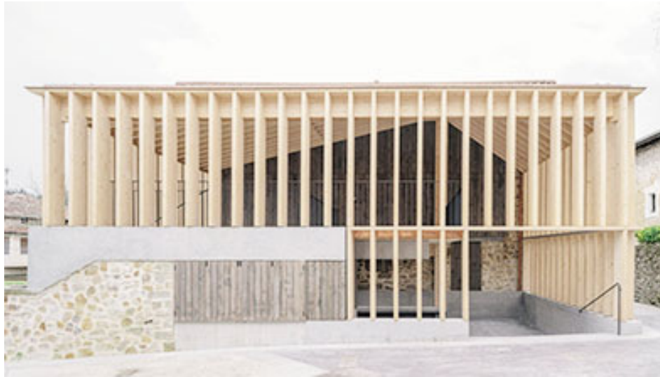
Funcionalmente el espacio se distribuye en dos plantas. Una planta baja diáfana, donde se coloca una pequeña barra abierta, multiusos, para eventos que se realicen. Y una entreplanta de pequeñas dimensiones, a la que se accede desde las escaleras exteriores.
