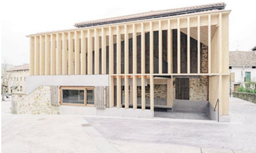
La estructura de cerramiento exterior es de madera laminada.
